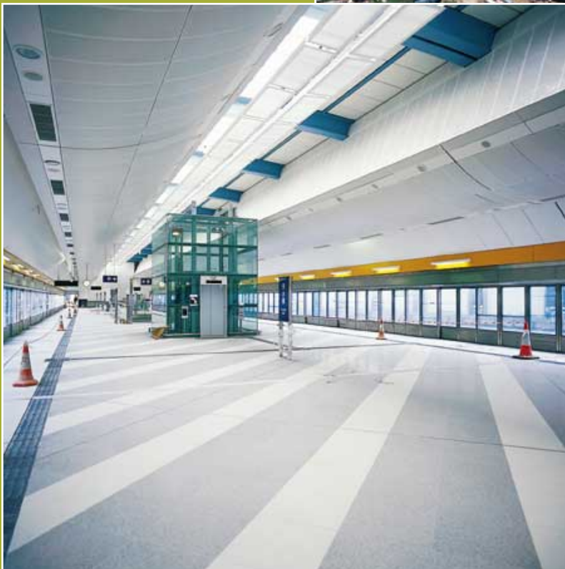
西鐵第一期工程 — 天水圍車站建築工程
