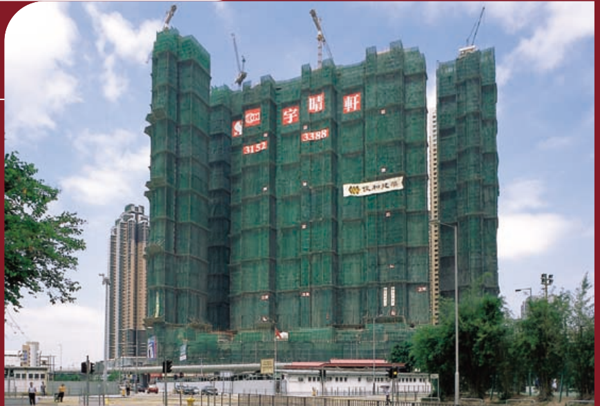
新九龍內地段6275號西九龍填海區 宇晴軒建築工程
