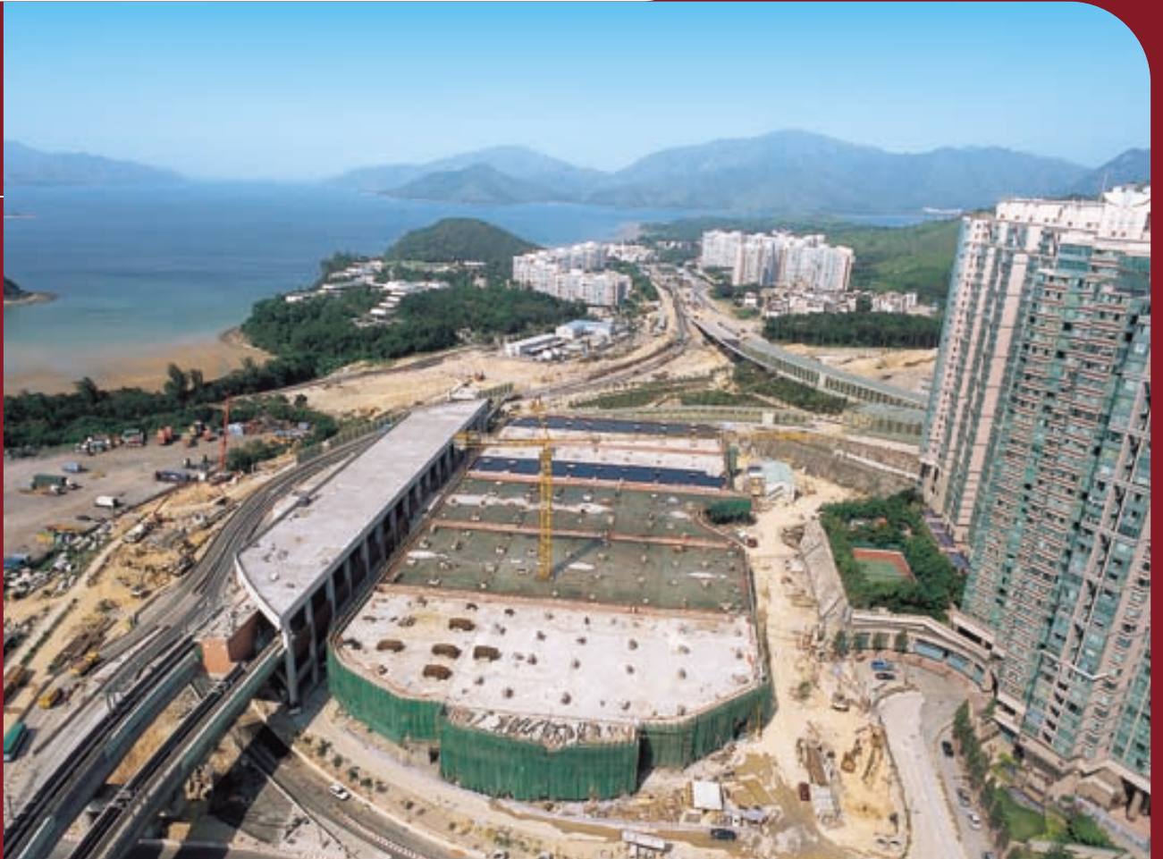
烏溪沙車站公共交通工具交匯處建築工程
