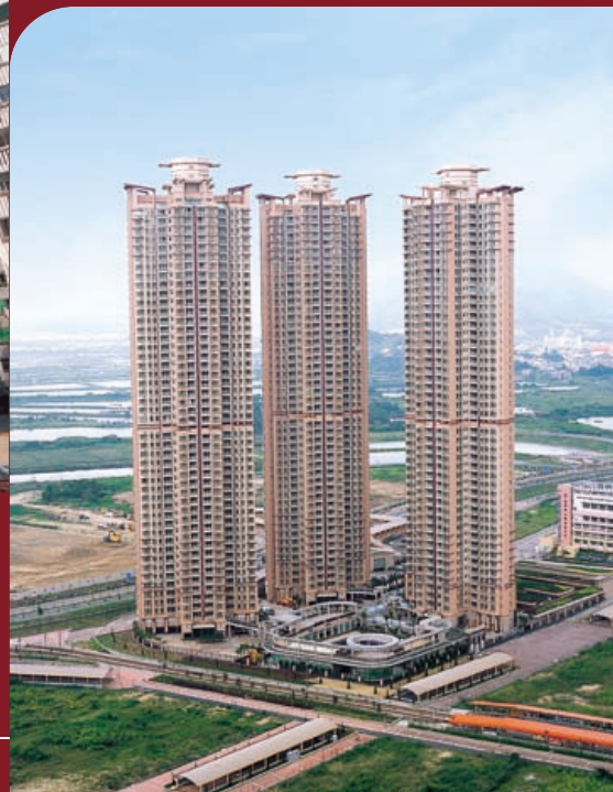
元朗天水圍市地段27號慧景軒建築工程
