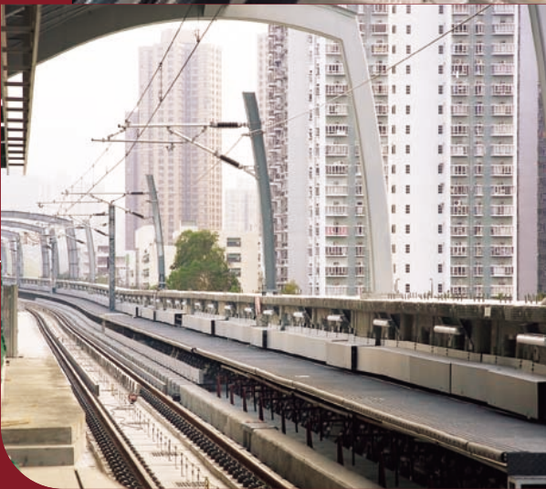
東鐵支線路軌工程
