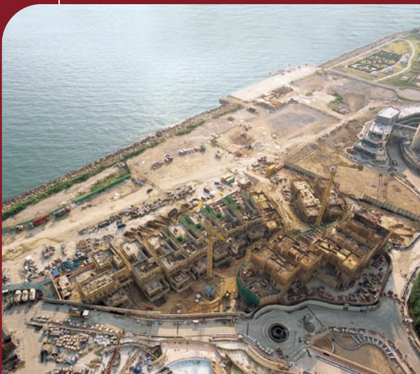
數碼港第二期住宅發展建築工程
