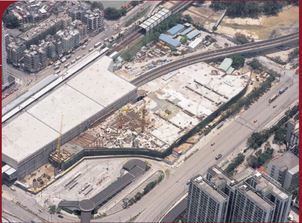
大圍車站公共交通工具 交匯處建築工程
