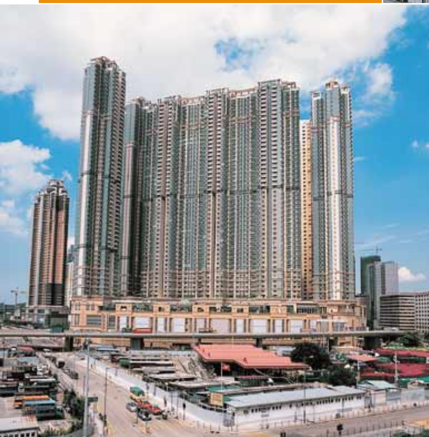
新九龍內地段6275號西九龍填海區宇晴軒建築工程
