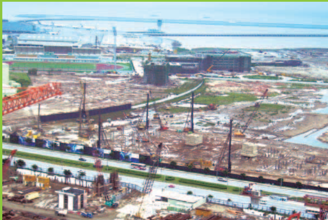
■ 澳門「新濠天地」地基工程
