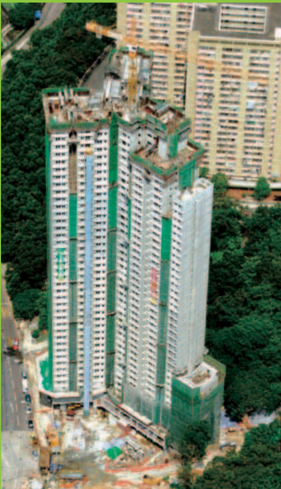
■ 香港房屋署黃大仙上邨第三期的建築工程
