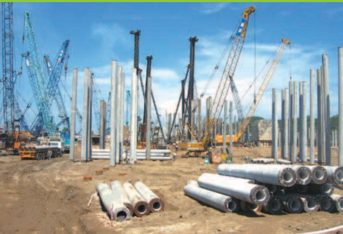
■ 澳門「星麗門」地基工程
