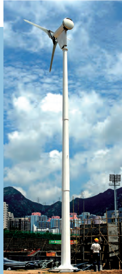
黃大仙蒲崗村道地區休憩用地 建造工程 - 機電裝置
