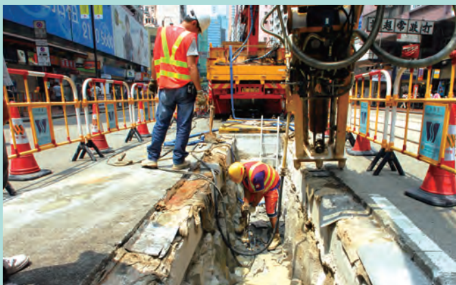
水務署合約編號28/WSD/06 —更換及修復水管工程第2階段 (港島北及港島西南水管工程)
