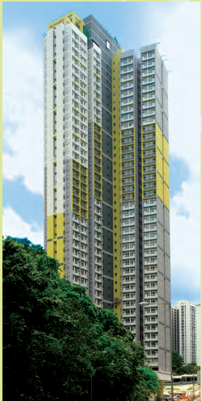
黃大仙上邨第三期的建築工程
