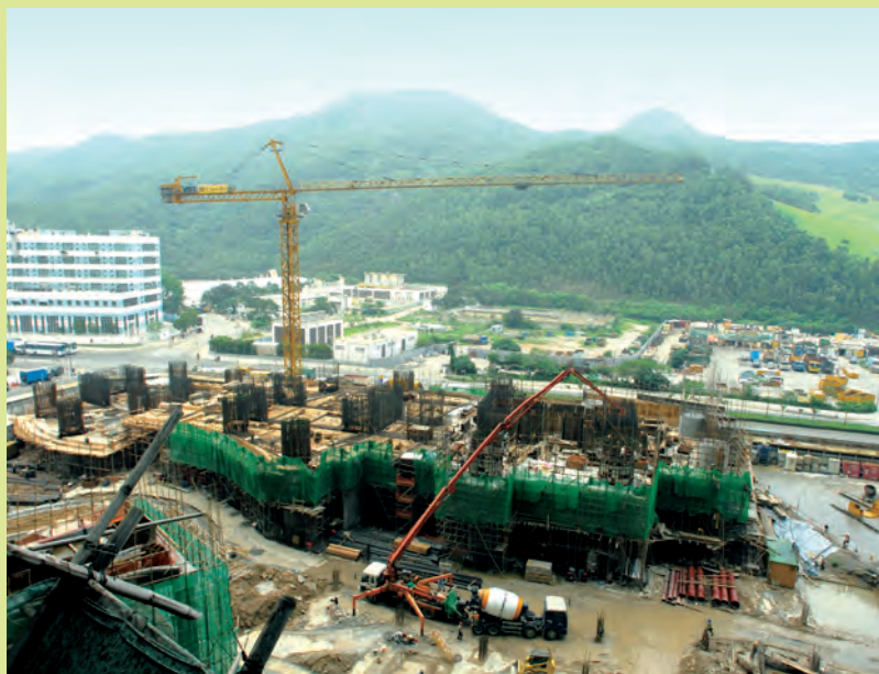
將軍澳市地段第70號86區AB地盤住宅項目之上蓋發展工程
