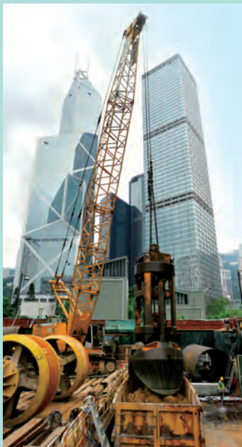
中環干諾道中三號商業大廈 (麗嘉酒店原址)地基工程
