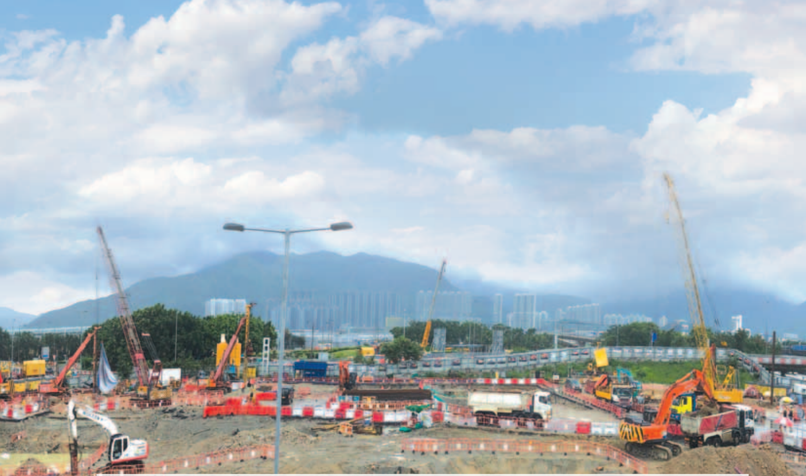
Hong Kong International Airport - Terminal 2 Foundation and Substructure Works 香港國際機場 - 二號客運大樓地基及下層結構工程
