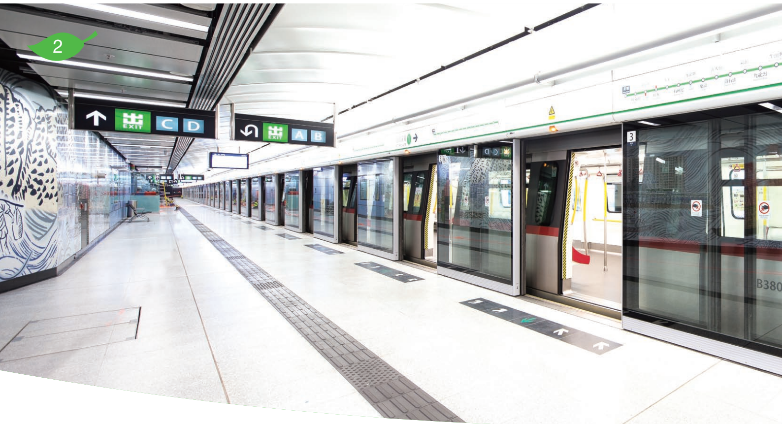
1&2 MTR Contract No. 1002 – Kwun Tong Line Extension: Whampoa Station and Overrun Tunnel 港鐵合約編號 1002 – 觀塘綫延綫：黃埔站及避車隧道建造工程
